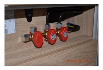
Die Position nach oben zeigt an, dass die Leitungen geöffnet sind
